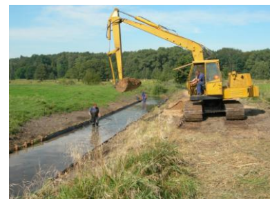
Budowa tarliska w Strudze Rybnickiej
