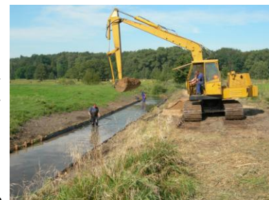
Budowa tarliska w Strudze Rybnickiej
